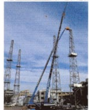
上／飯田橋駅西口地区 第一種市街地再開発事業（2011年） 下／向原モダンゴルフ解体工事（2014年）
