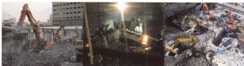
左／築地5丁目計画 旧三井造船地下 (2010年) 中央／ラフォーレ原宿 改修工事 (2011年) 右／日本橋1丁目プロジェクト解体工事 (2012年)
